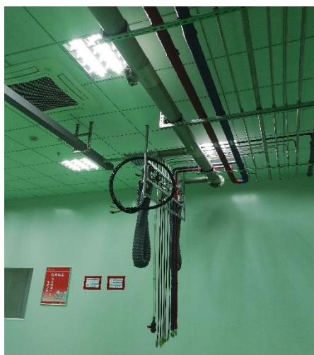
燃烧测试废气收集管道
