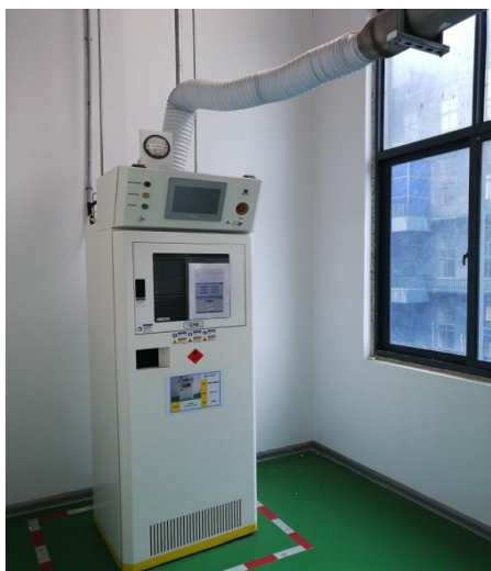
甲烷输送柜和泄漏气体收集管道
