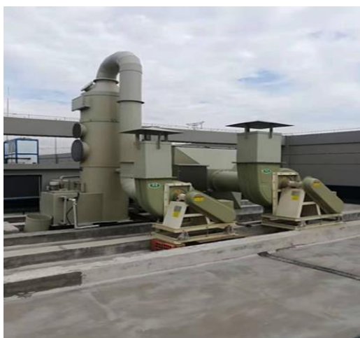
实验室废气处理装置及排气筒 (活性炭+碱吸附装置)
