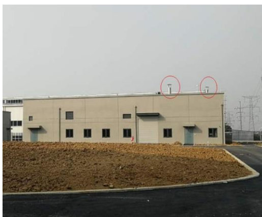
2 根燃气锅炉废气排气筒
