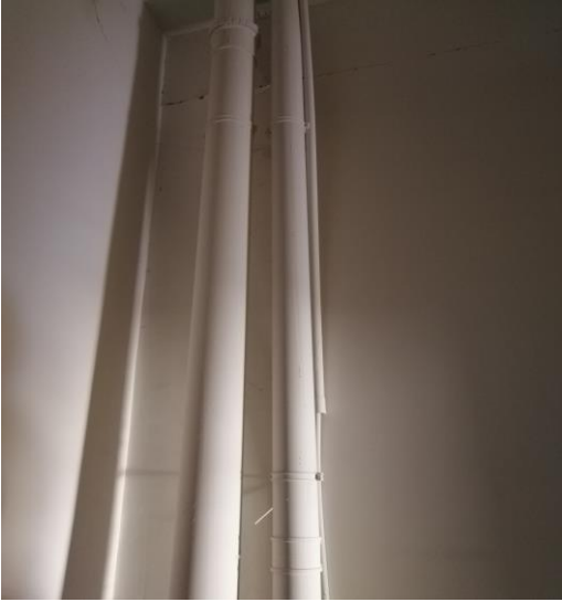
污水处理站废气排放管道 (通至楼顶)
