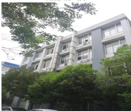
厂房外北侧废气管道（引至楼顶）
