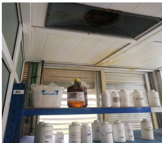
化学品存放区及上方废气收集口
