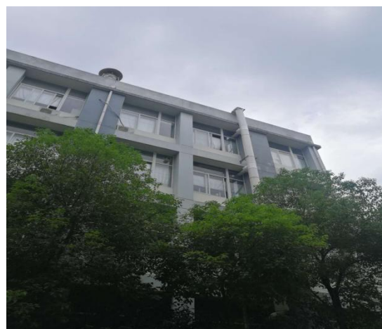
厂房外东侧废气管道（引至楼顶）
