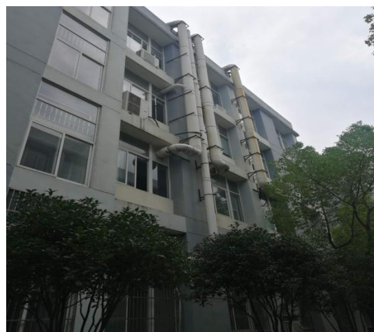
厂房外南侧废气管道（引至楼顶）
