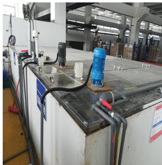
污水处理设施顶部密闭加盖 (依托广豪汽车配件(合肥)有限公司)
