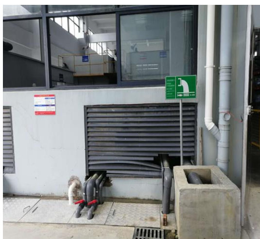
厂区污水处理站排放口
