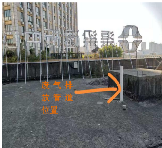
污水处理站废气排放管道（通至楼顶）
