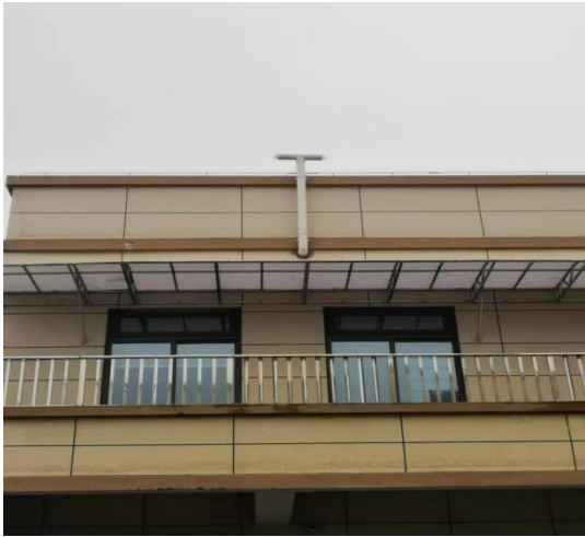
污水处理站废气排放管道（通至楼顶）
