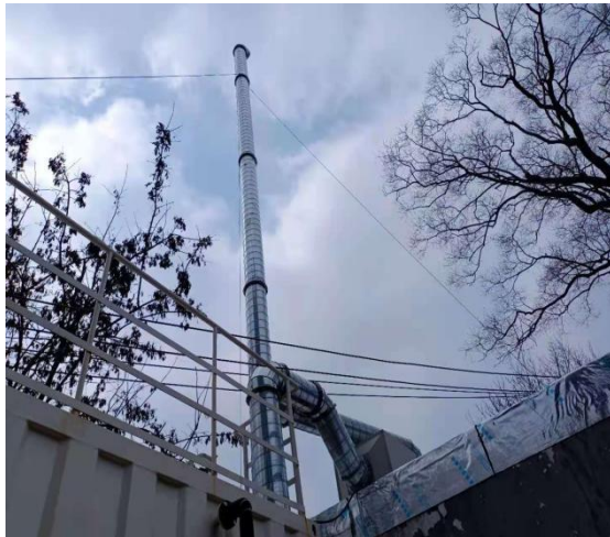
废气处理设施（活性炭吸附装置+15m 排气筒）
