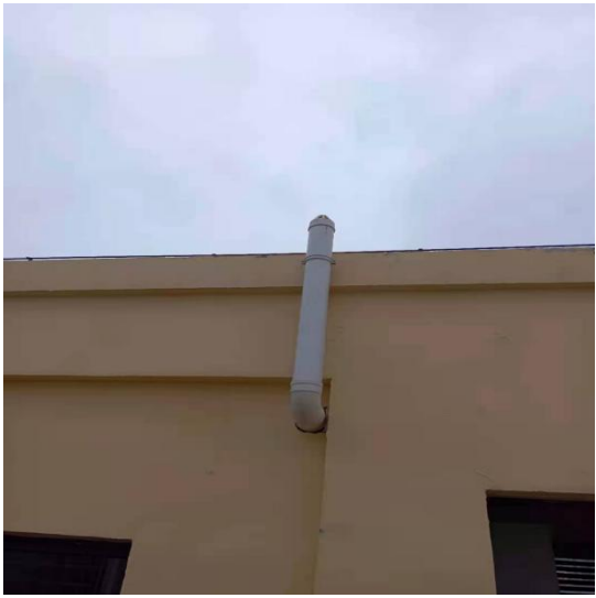
废气排气筒（引至楼顶，约 15m）
