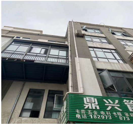
污水处理站废气排放管道（通至楼顶）
