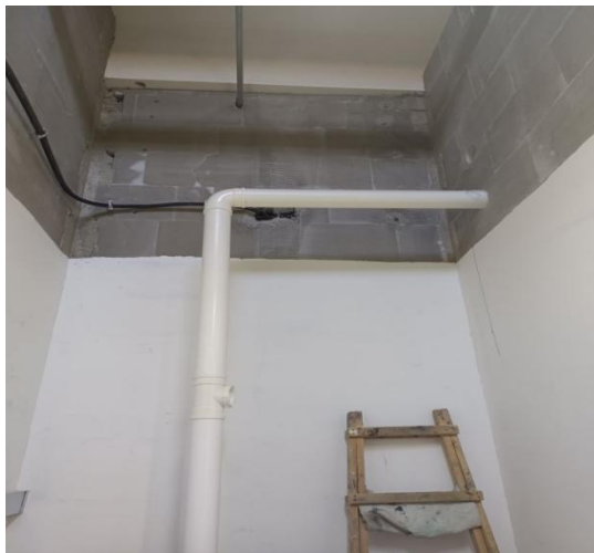
污水处理站废气排放管道（通至楼顶）
