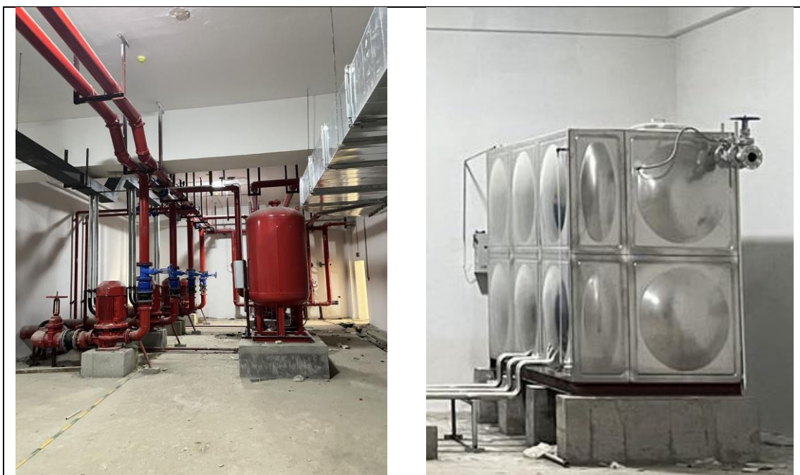
图 3-1 消防泵房、生活泵房降噪措施
