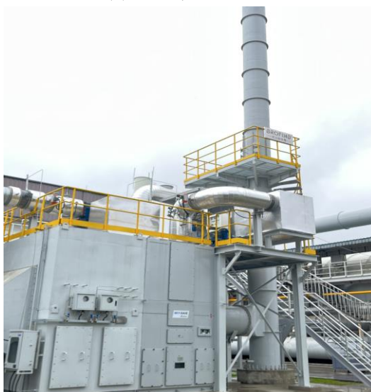
沸石转轮浓缩装置及10#排气筒
