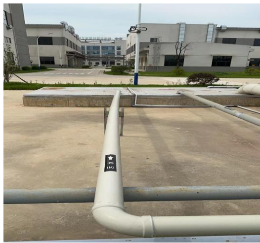
污水输送管线（明管架空、走向标识）
