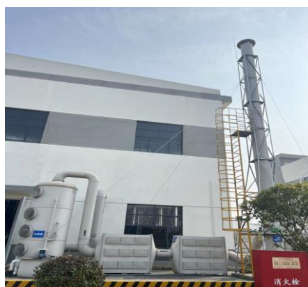
2#水喷淋塔+二级活性炭吸附装置及 2#排气筒
