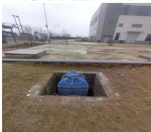
厂区雨水总排口截断阀
