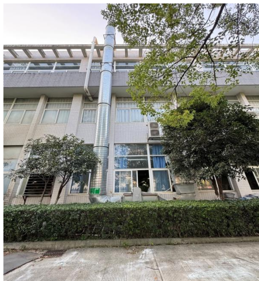
图 3-2 2#二级活性炭吸附装置及 2#废气排气筒照片
