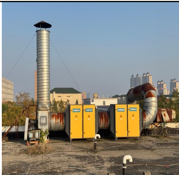
图 3-2 2#二级活性炭吸附装置及 2#废气排气筒照片
